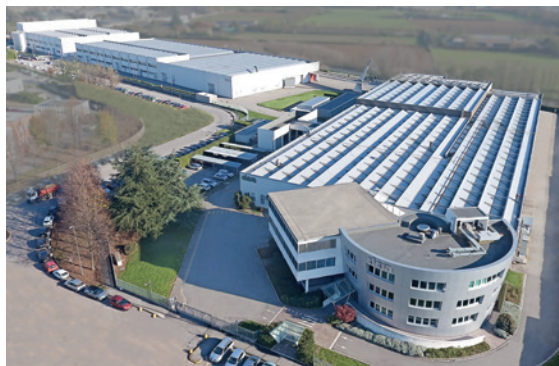
Instalaciones de producción en Monza (Italia)
